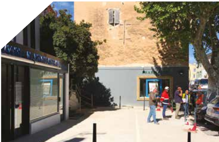
Suivi de chantier de rénovation du centre ville
