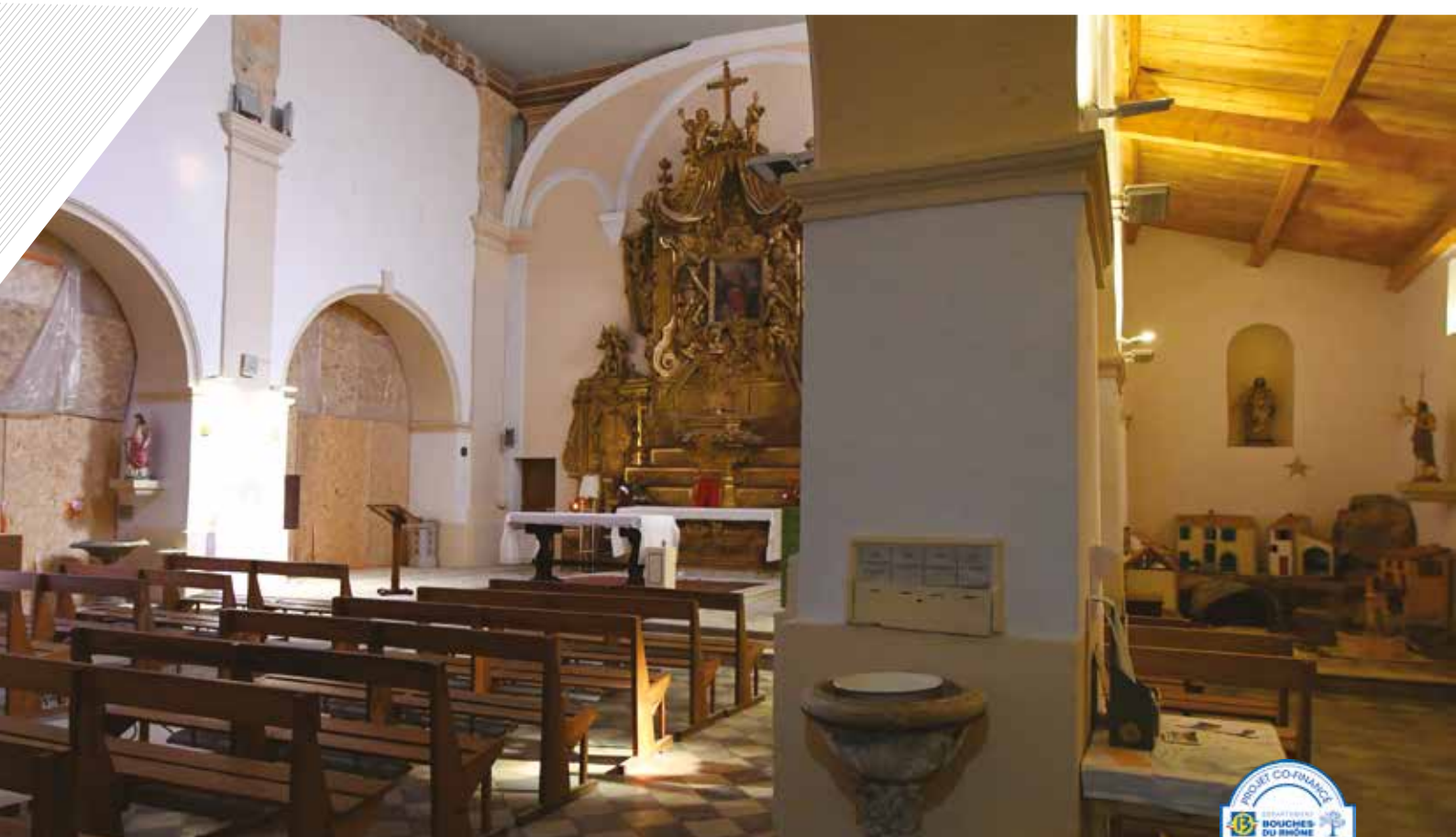
La rénovation de l'église Notre Dame de l'Assomption s'achève avec les finitions sur la nef gauche
