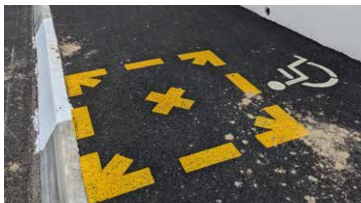
Rénovation des arrêts de bus par la Métropole - Septembre 2023
