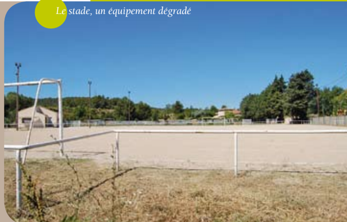
Le stade, un équipement dégradé
